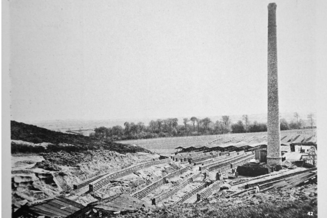
42 : Briquetterie construite sur place pour alimenter le chantier de construction.
